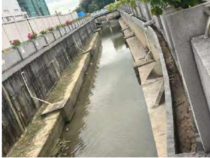
图3.6-3 排洪渠现场图
